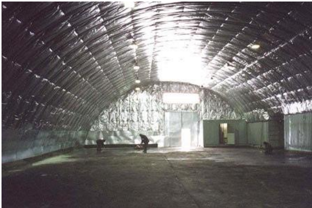
Утепление бескаркасного ангара
