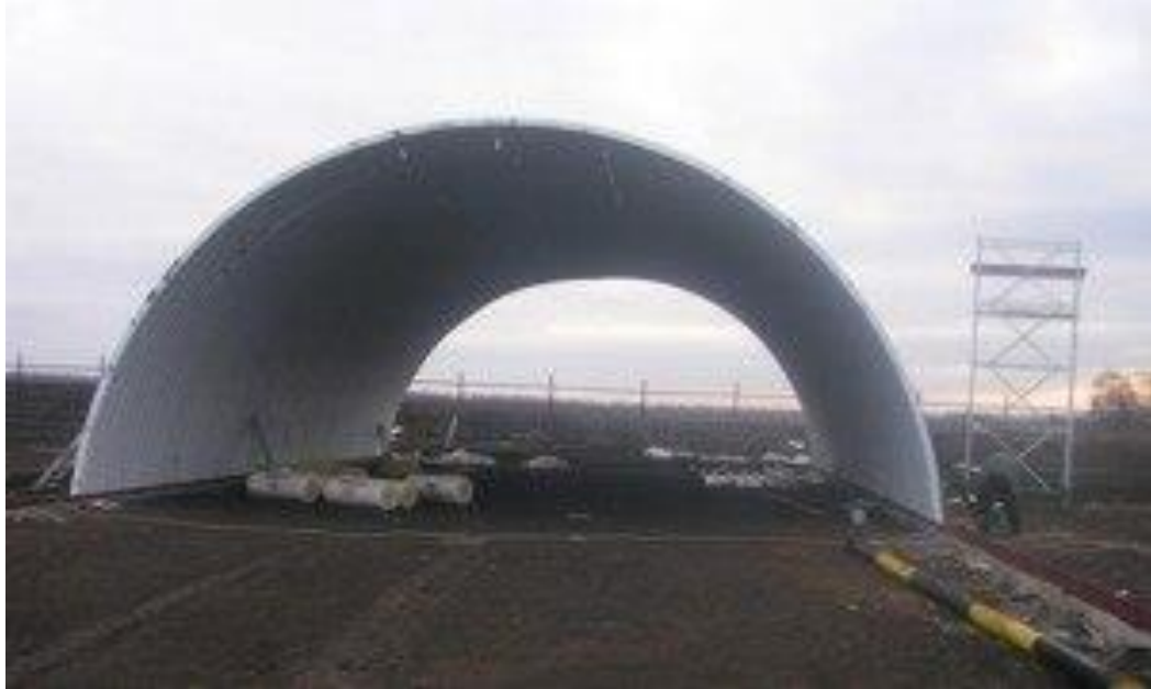
Строительство бескаркасного ангара, вид арок
